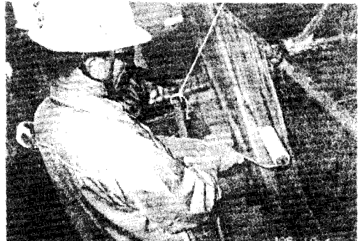
<사진6.> 침투성 알카리부여제의 도포
