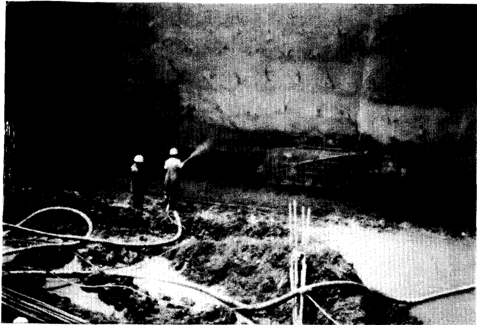
그림 4.5 표면보호공(2차 슛크리트) 시공장면
